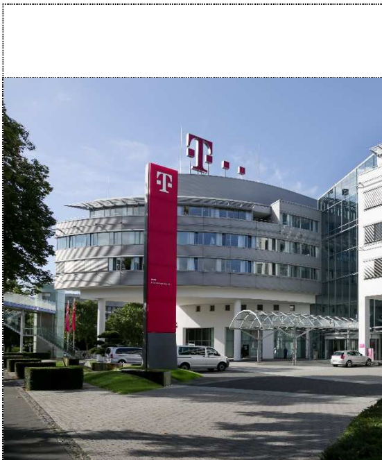
Telekom-Zentrale in Bonn Bildquelle / Nutzungsrechte: Deutsche Telekom AG
