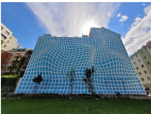
Eine Brandmauer im Leonie-Rysanek-Park gestaltet von Peter Kogler Bildquelle / Nutzungsrechte: Art-Invest Real Estate
