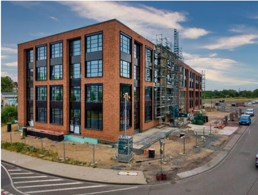
Aktuelle Baustellenaufnahmen des HANGAR Bildquelle / Nutzungsrechte: Art-Invest Real Estate | OSMAB Holding AG
