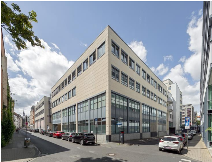
Ansicht des Ärztehauses Ecke Domstraße/Unter Krahenbäumen Bildquelle / Nutzungsrechte: Stefan Schilling
